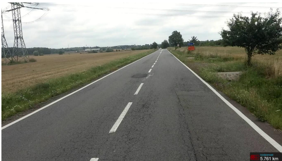
Obrázek 1 – Síťové trhliny a plošné deformace v pokročilém stádiu vývoje
